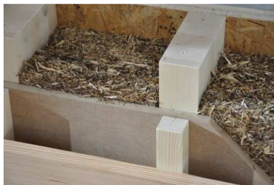
Wandaufbau mit strohbasierten Dämmstoffplatten
